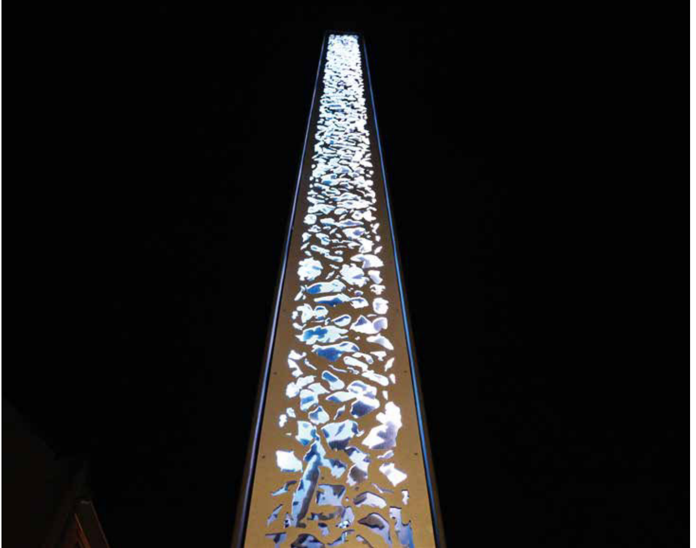
Abb.: 10 Meter hohe, feuerverzinkte und grau lackierte Stahl-Lichtstelen umrahmen und beleuchten den »Lindeplein« in der Kleinstadt Brunssum. Nachts leuchten die Stelen in verschiedenen Farben, bei Tageslicht hat man das Gefühl, dass man durch die Stele hindurchschauen kann.
